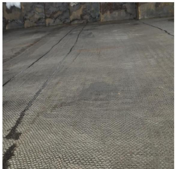
储罐区玻璃钢防腐防渗
